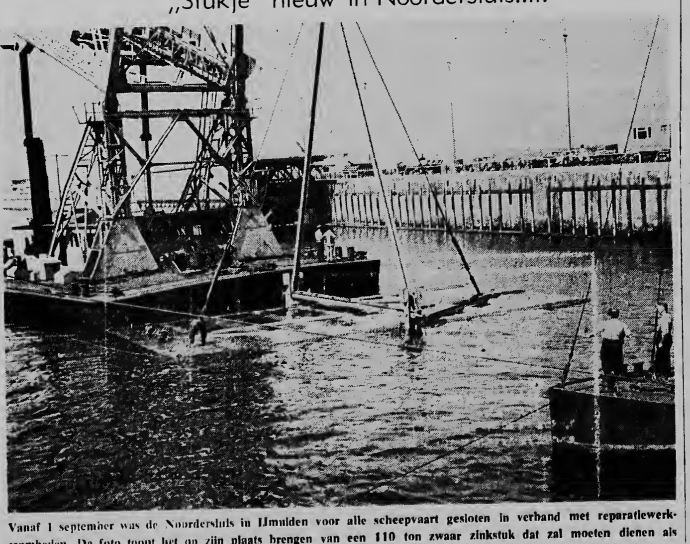
Vanaf 1 september was de Noordersluis in IJmuiden voor alle scheepvaart gesloten in verband met reparatiewerkzaamheden. De foto toont het op zijn plaats brengen van een 110 ton zwaar zinktstuk dat zal moeten dienen als steun voor de zware sluisdeuren.
